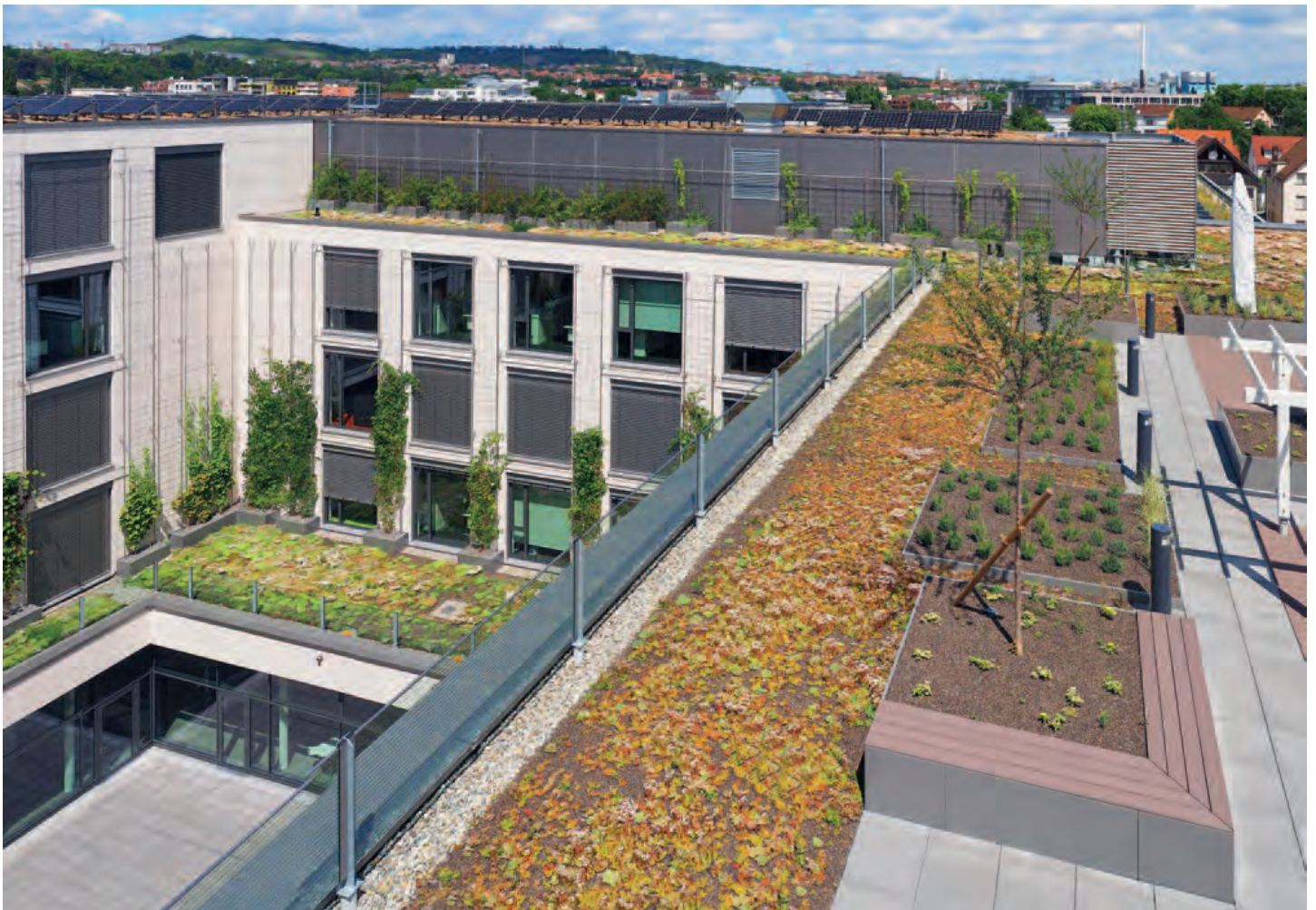
Foto: Troggebundener Begrünung mit Kletterpflanzen (Quelle: DACHBEGRÜNUNG Garten-Moser GmbH u. Co. KG, Reutlingen)
